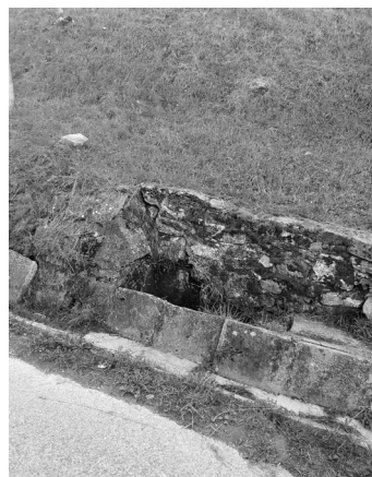
studnička pred rekonštrukciou
