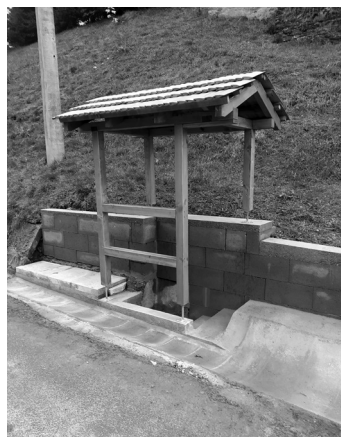
Studnička po rekonštrukcii
